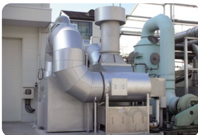
食品工場向け 処理量：170m 3 N/min
