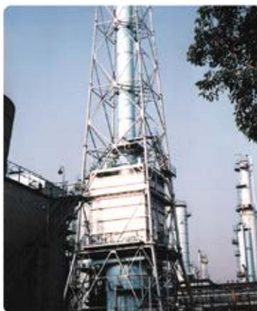
石油精製プラントボイラ排ガス処理システム
