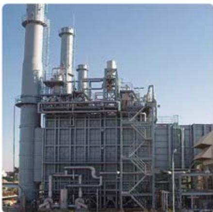
ガスタービン発電プラント排ガス処理システム
