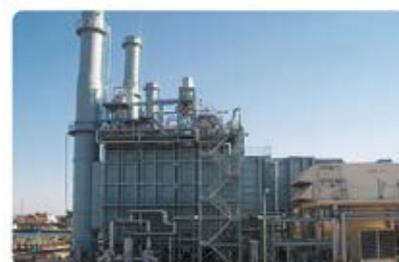
脱硝装置 / De-NOx system
